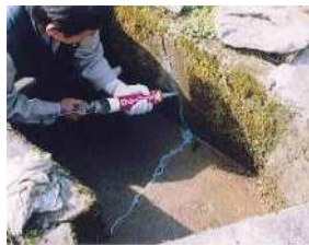
水路のひび割れ補修
