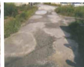
農道の窪みの補修
